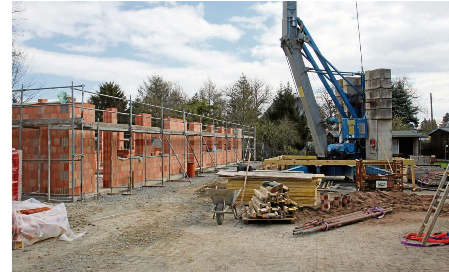
Bau des Gemeinschaftshauses im Feriendorf am Schwanenteich kommt voran. Die ersten Anmeldungen gibt es.
