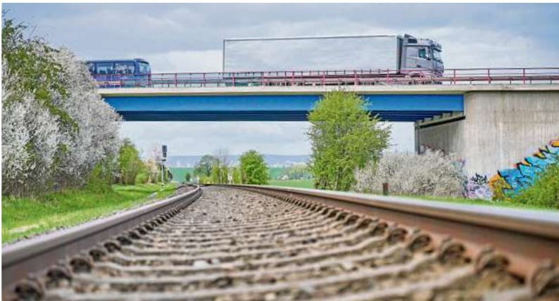
Nahe Bad Langensalza führt die Bahnstrecke Gotha-Leinefelde unter der Bundesstraße 247 hindurch. Eine Elektrifizierung der Strecke war beim Bau noch nicht vorgesehen.
