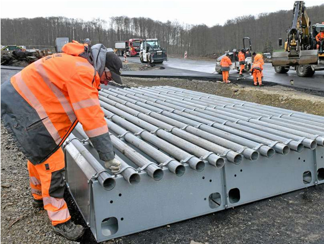
Entlang der neuen Ortsumfahrung Kallmerode werden auf einer Strecke von etwa einem Kilometer zwei Wechselkorridore von je 70 Metern Breite gebaut. Damit die Tiere ausschließlich im vorgesehenen Wechselbereich die Straße queren, kommen zur Lenkung des Wildes Wildroste zum Einsatz, wie sie hier von Vorarbeiter Norman Dumaire montiert werden..
