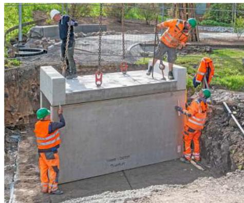
Von oben links im Uhrzeigersinn: An einem schweren Autokran hängt der Deckel. In Apolda. Der Deckel wird auf den Durchlass vorsichtig abgelegt. Zurechtrücken des Deckels auf dem Kern-Element des Durchlasses. Die Pflasterarbeiten an der Promenade schreiten voran.
