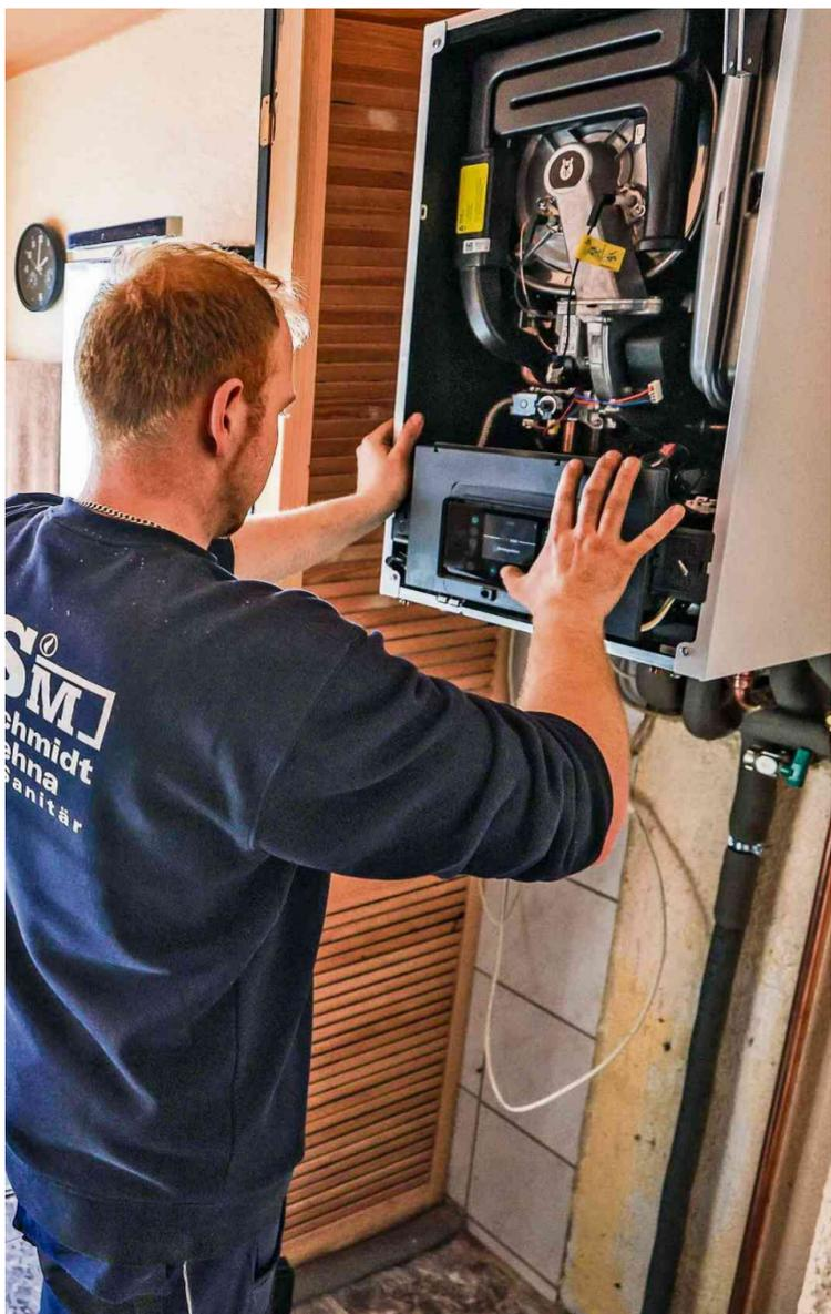
Ein Mitarbeiter einer Sanitär- und Heizungsbaufirma installiert eine moderne Gasbrennwerttherme in einem Einfamilienhaus. Foto: dpa/Jan Woitas
