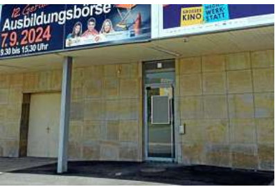
Zugang zur neuen öffentlichen Toilette unter den Veranstaltungsbänken.
