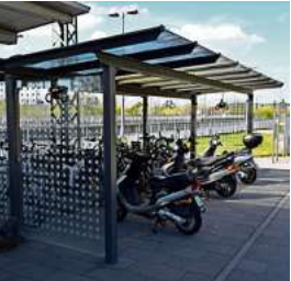
Stellplätze am Bahnhof. Foto: Stadt Hünfeld
