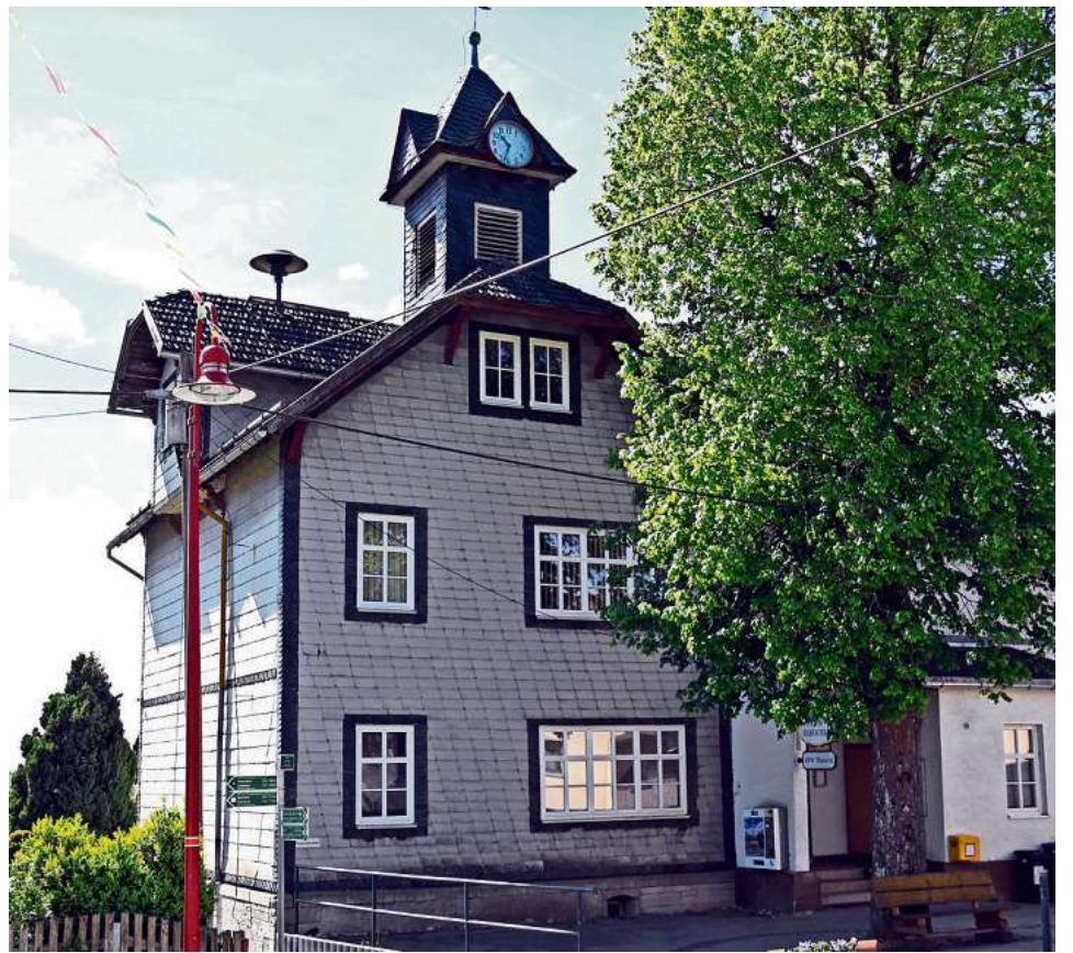
Die Asbestschindeln am Bürgerhaus in Theuern sollen verschwinden und der Eingangsbereich barrierefrei gestaltet werden. Fotos: Carl-Heinz Zitzmann
