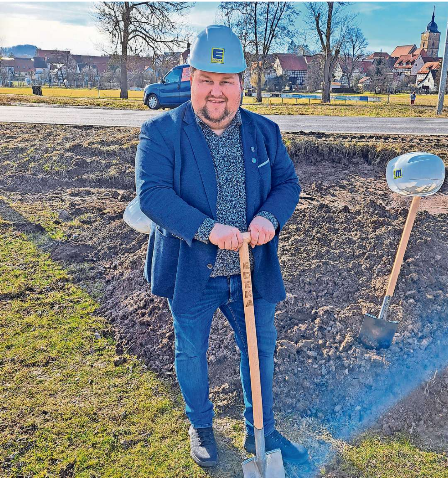
Christopher Other beim Spatenstich: Heldburg bekommt einen neuen Supermarkt. Baustart soll dieses Jahr sein.
