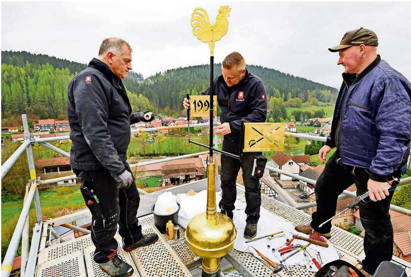
Uwe Nothnagel, Patrick Krebs und Ronny Eckstein (von links) sorgen dafür, dass die sanierte Turmbekrönung wieder fest sitzt. Foto: M. Bauroth
