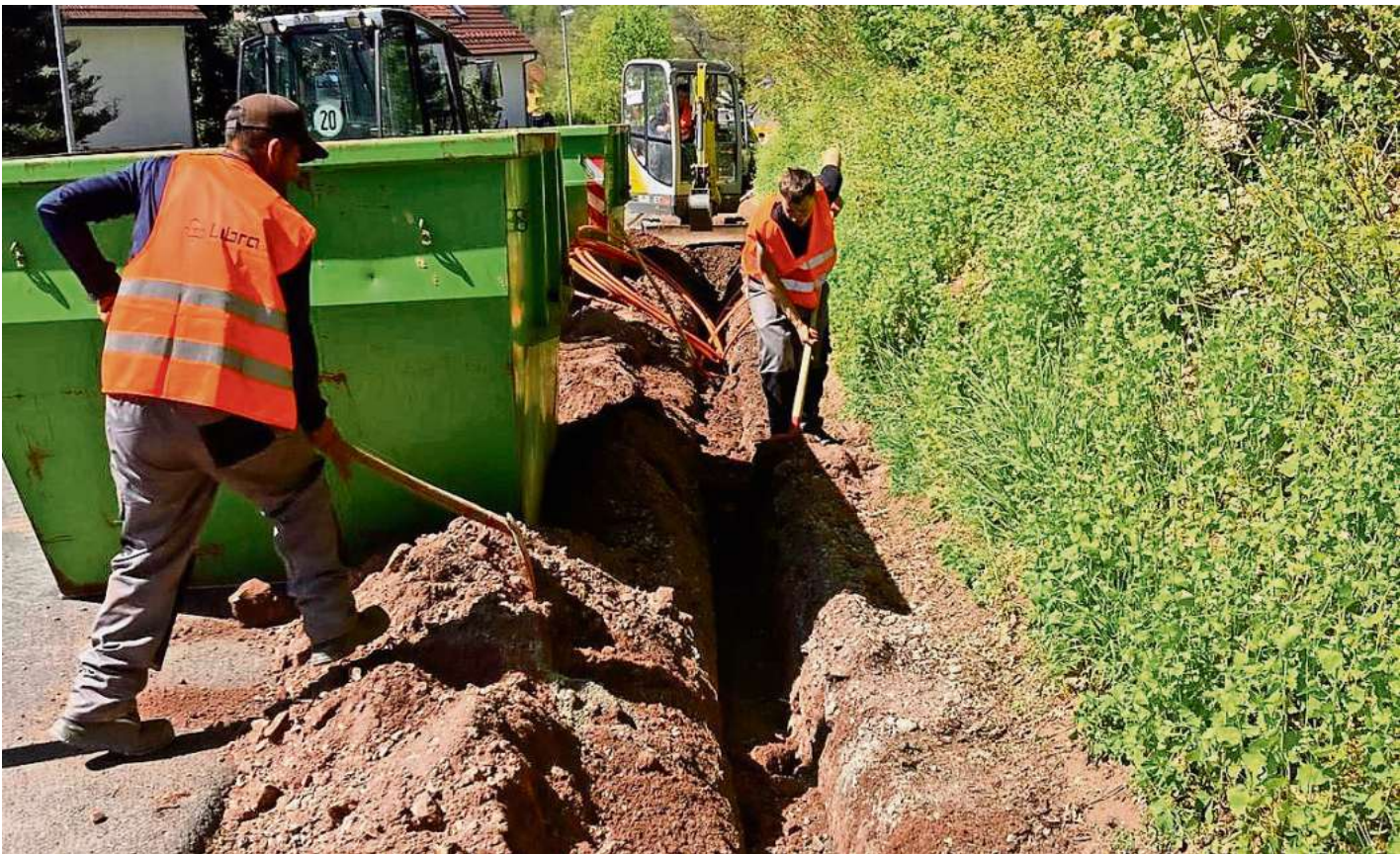
Bahn frei für schnelles Internet: Der Graben für die dafür notwendigen Glasfaserkabel wird gezogen.
