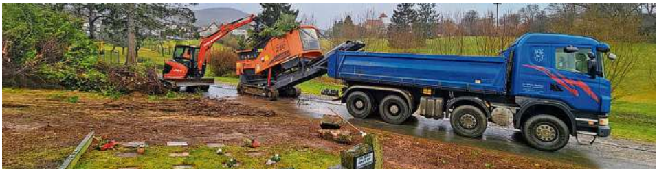
Heckenberäumung mit schwerem Gerät.
