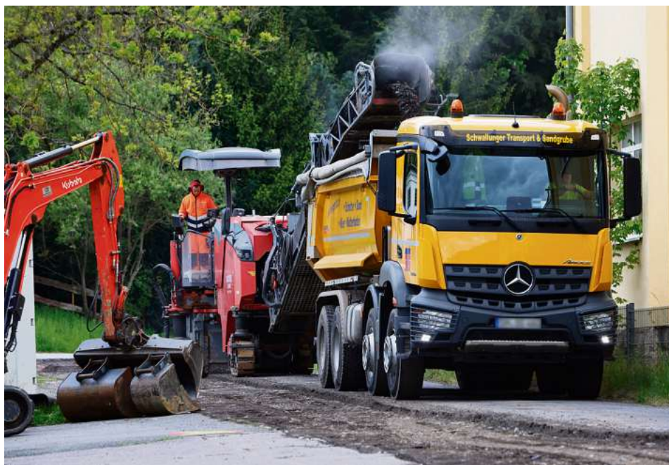
Der grundhafte Ausbau der Poppstraße in Benshausen hat begonnen.
