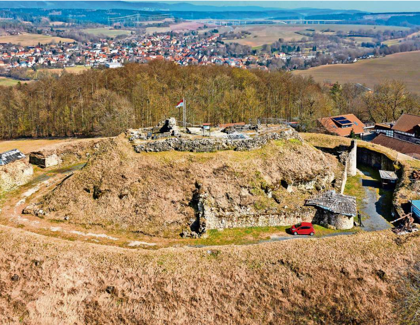
Blick über die Burgruine Schaumberg bei Schalkau und zur ICE-Brücke.
