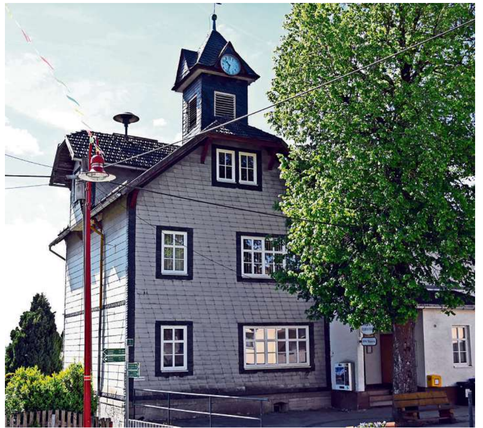
Die Asbestschindeln am Bürgerhaus in Theuern sollen verschwinden und der Eingangsbereich barrierefrei gestaltet werden.
