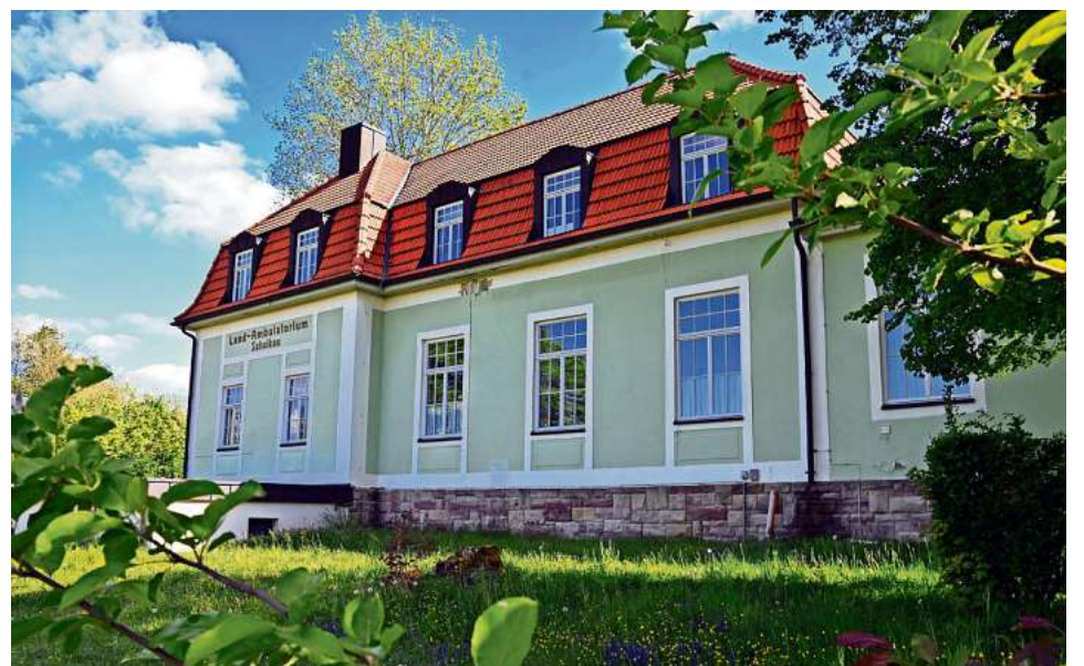
Das einstige Landambulatorium in Schalkau könnte einmal ein weiteres MVZ jenseits von Sonneberg und Neuhaus am Rennweg werden.
