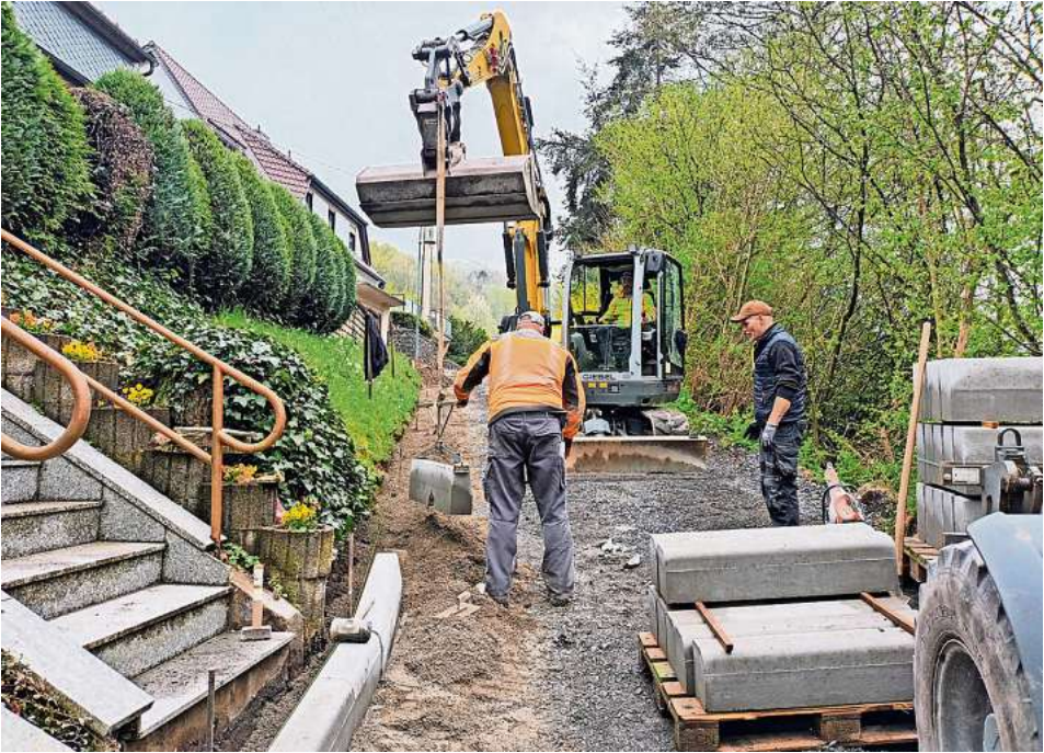
Mitte Mai sollen die Arbeiten in der „Winterliete“ abgeschlossen sein.
