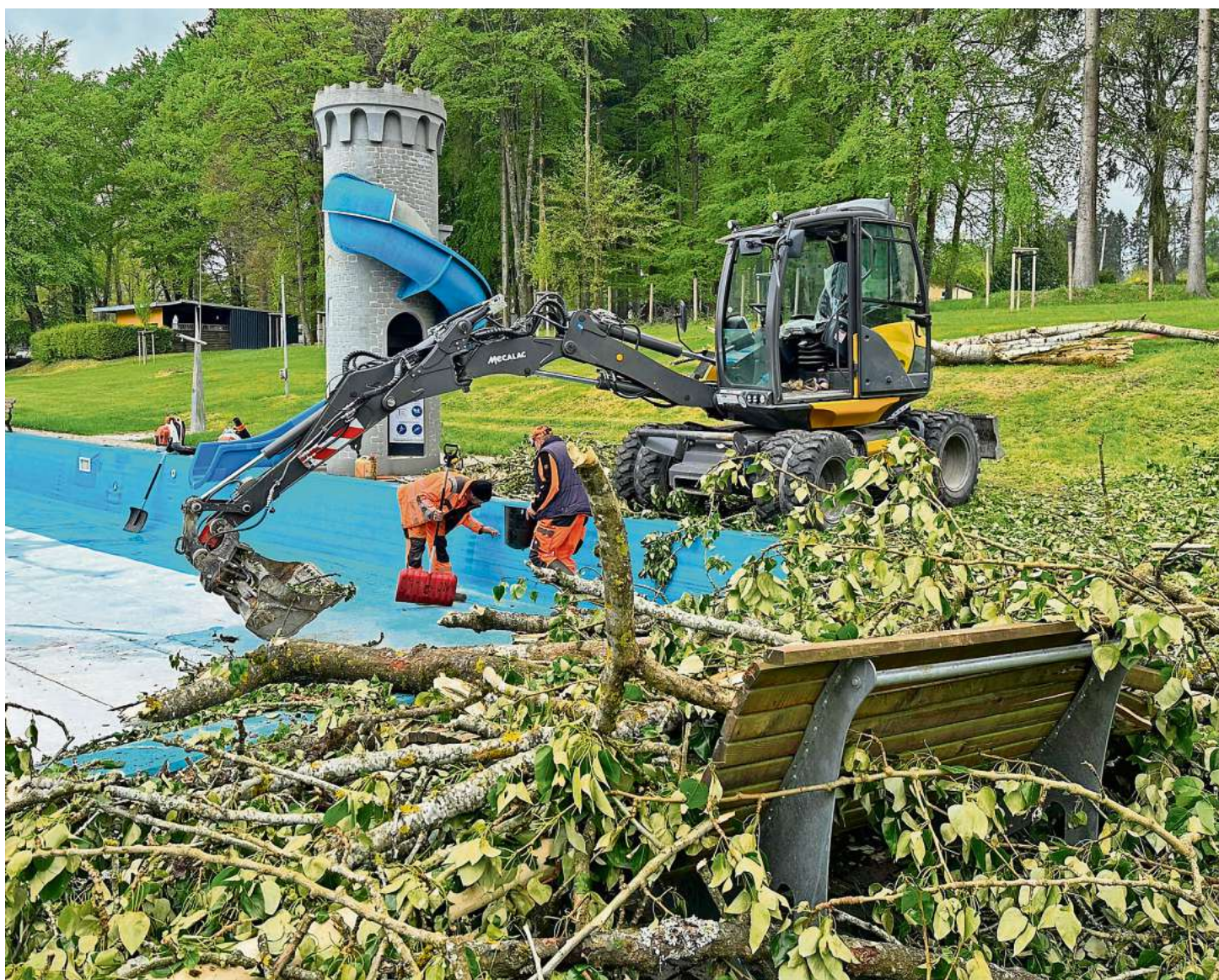
Ralf Sommer (re.) bei der Überprüfung von möglichen Schäden durch Äste am Schwimmbecken.
