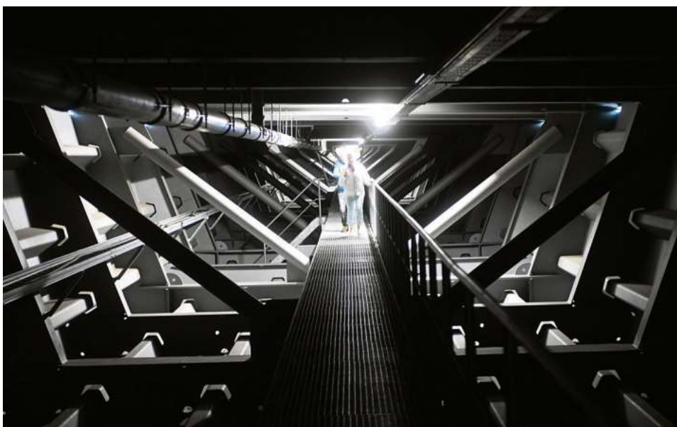
Ein Blick in die Haseltalbrücke zeigt den ausgeklügelten Aufbau. Foto: Bastian Frank
