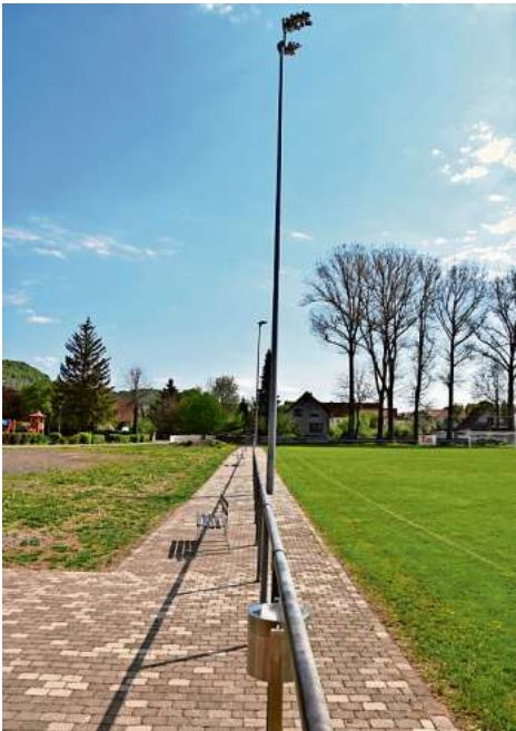
Neue Spielfeldbarriere und Flutlichtanlage in Kaltennordheim.
