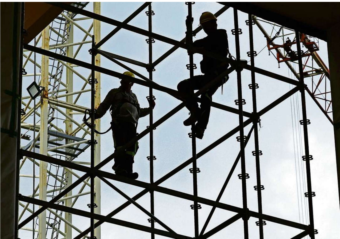
Dunkle, konjunkturelle Schatten: Europaweit hat es Firmen der Baubranche bei den Insolvenzen am schwersten erwischt. Foto: picture alliance/dpa
