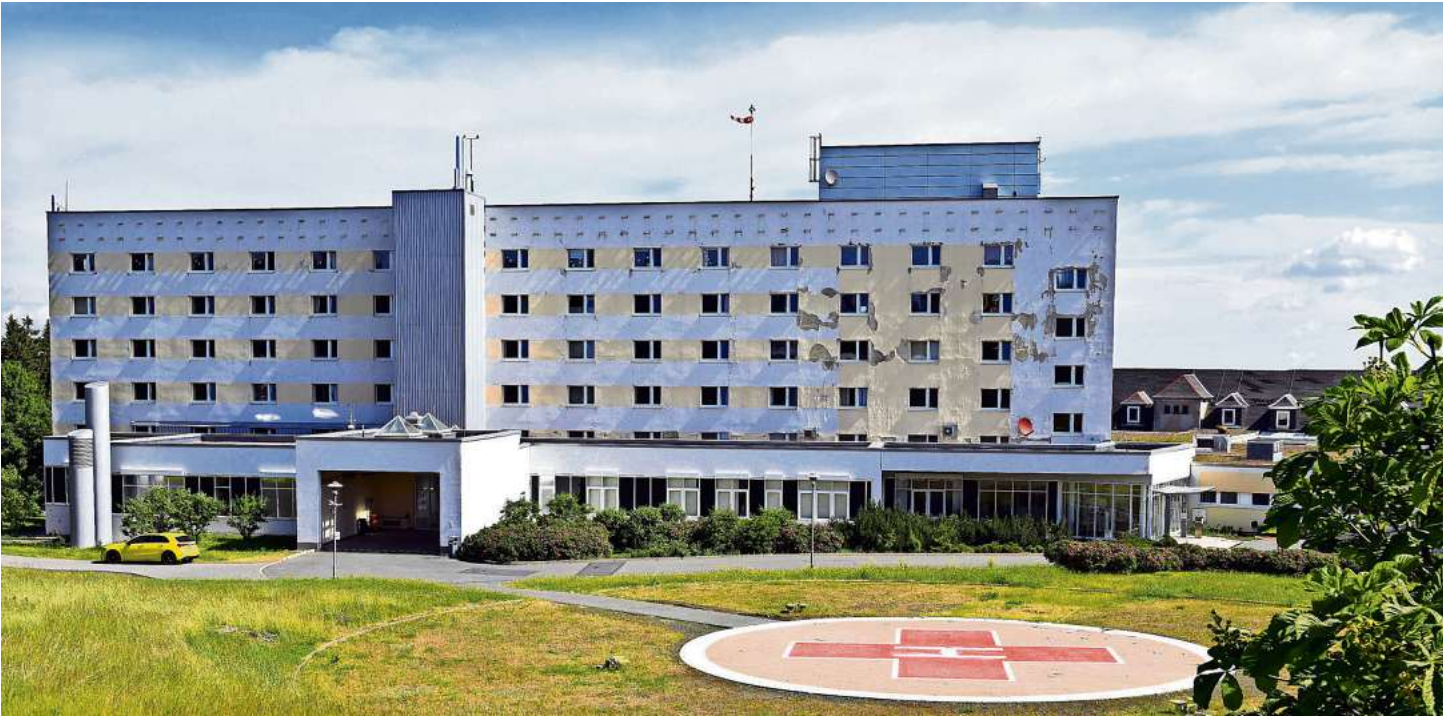
Auf drei Etagen des ehemaligen Rennsteigstadt-Klinikums würde der Kreis sich gern ein Wohnraum-Projekt fördern lassen, das Menschen mit Pflegestufe 1 zugute kommt. Angesichts bereits bestehend hoher Leerstände in Neuhaus fürchten die beiden lokalen Wohnungsunternehmen im Ergebnis massive Verschiebungen zu ihren Lasten. Der Stadtrat schließt sich dieser Skepsis an. Fotoarchiv: Carl-Heinz Zitzmann
