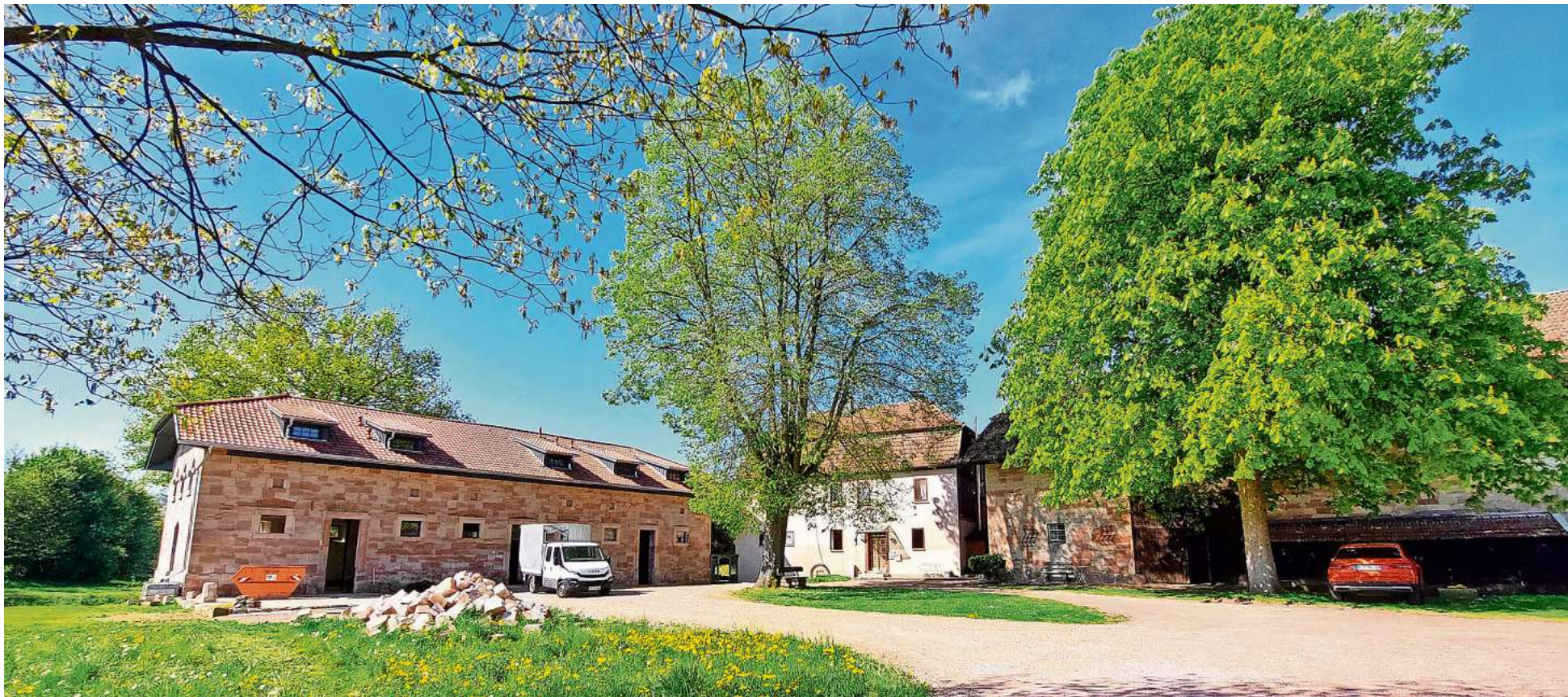
Das Kulturdenkmal Engelshof: links die ehemalige Tabakfabrik, in der Mitte das auf einem Fundament aus dem Jahr 1615 in den 1920er-Jahren aufgebaute Wohnhaus, rechts die Scheune. Der Schwesterbau der einstigen Fabrik, ein ehemaliger Schafstall, wurde laut alten Unterlagen 1912 an die Domäne Craimar verkauft und dort wieder aufgebaut.
