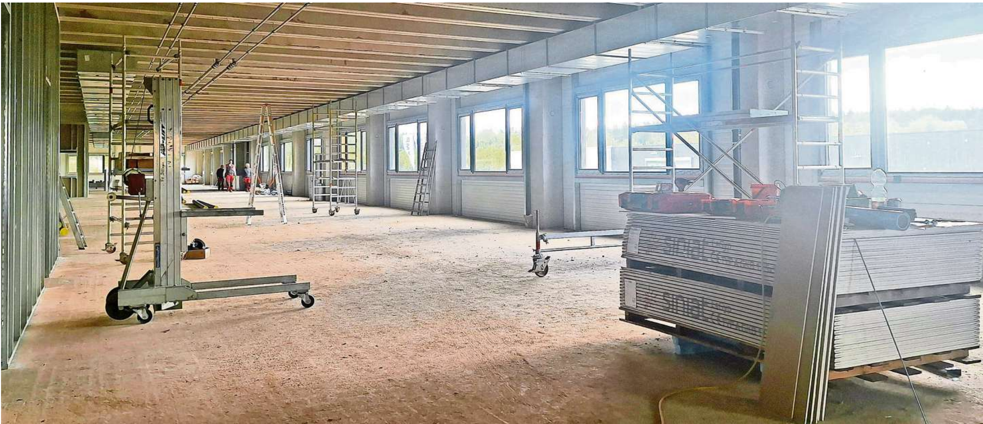
Ein Blick in die zukünftige Kantine am neuen Ilmenauer Standort.
