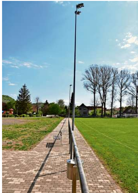
Neue Spielfeldbarriere und Flutlichtanlage in Kaltennordheim.
