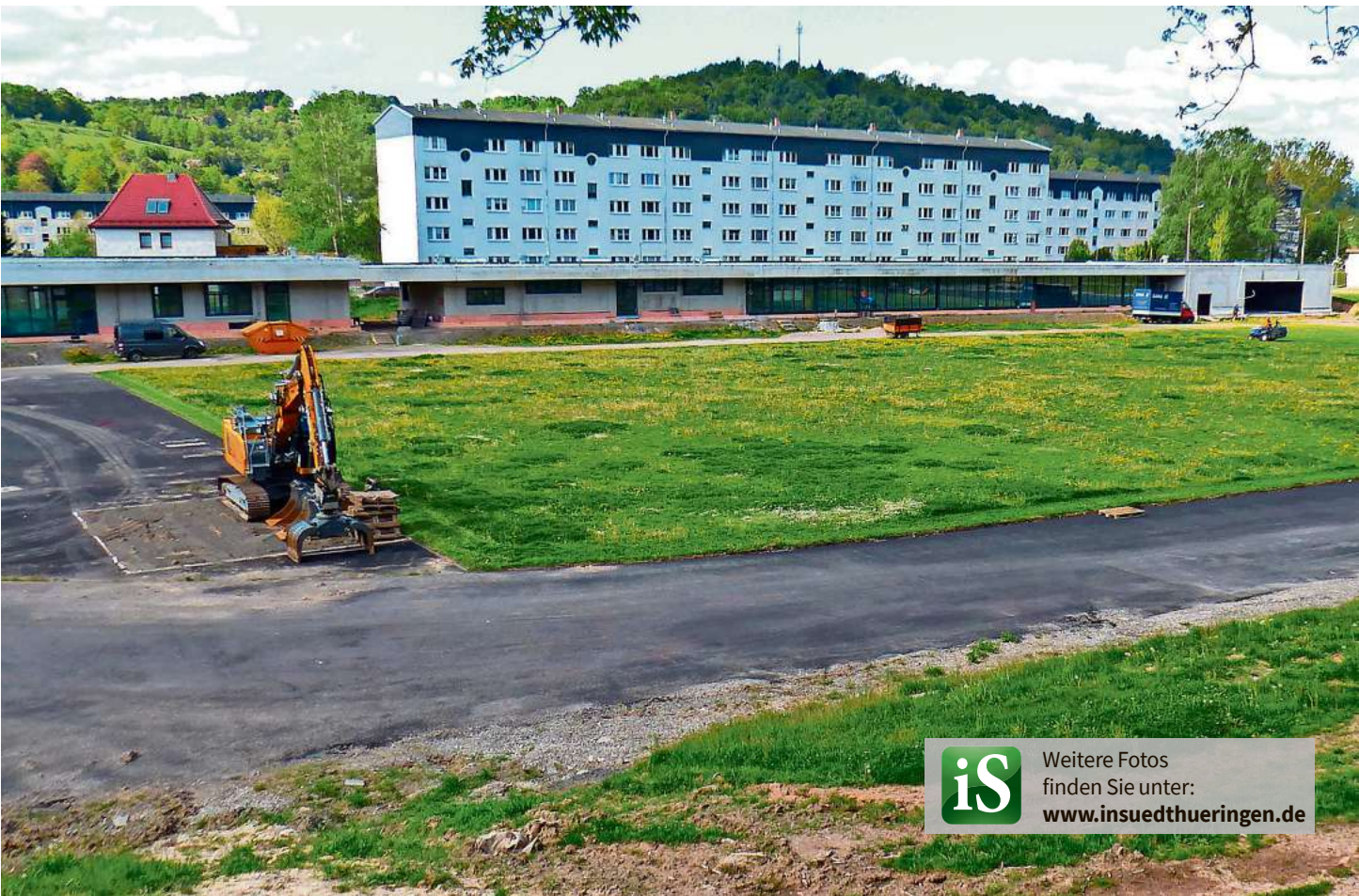
Das im Umbau befindliche Stadion in Schmalkalden. Auch hier wurde schon einiges geschafft.
