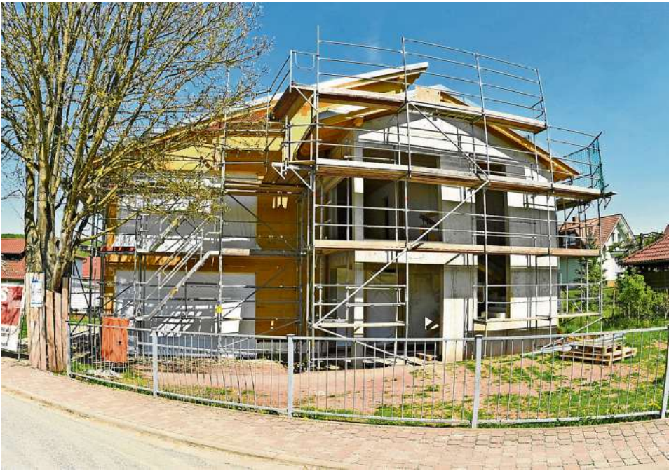
Zügig voran gehen die Arbeiten am Neubau des Kindergartens in Neubrunn, das größte Vorhaben der Gemeinde im laufenden Jahr.
