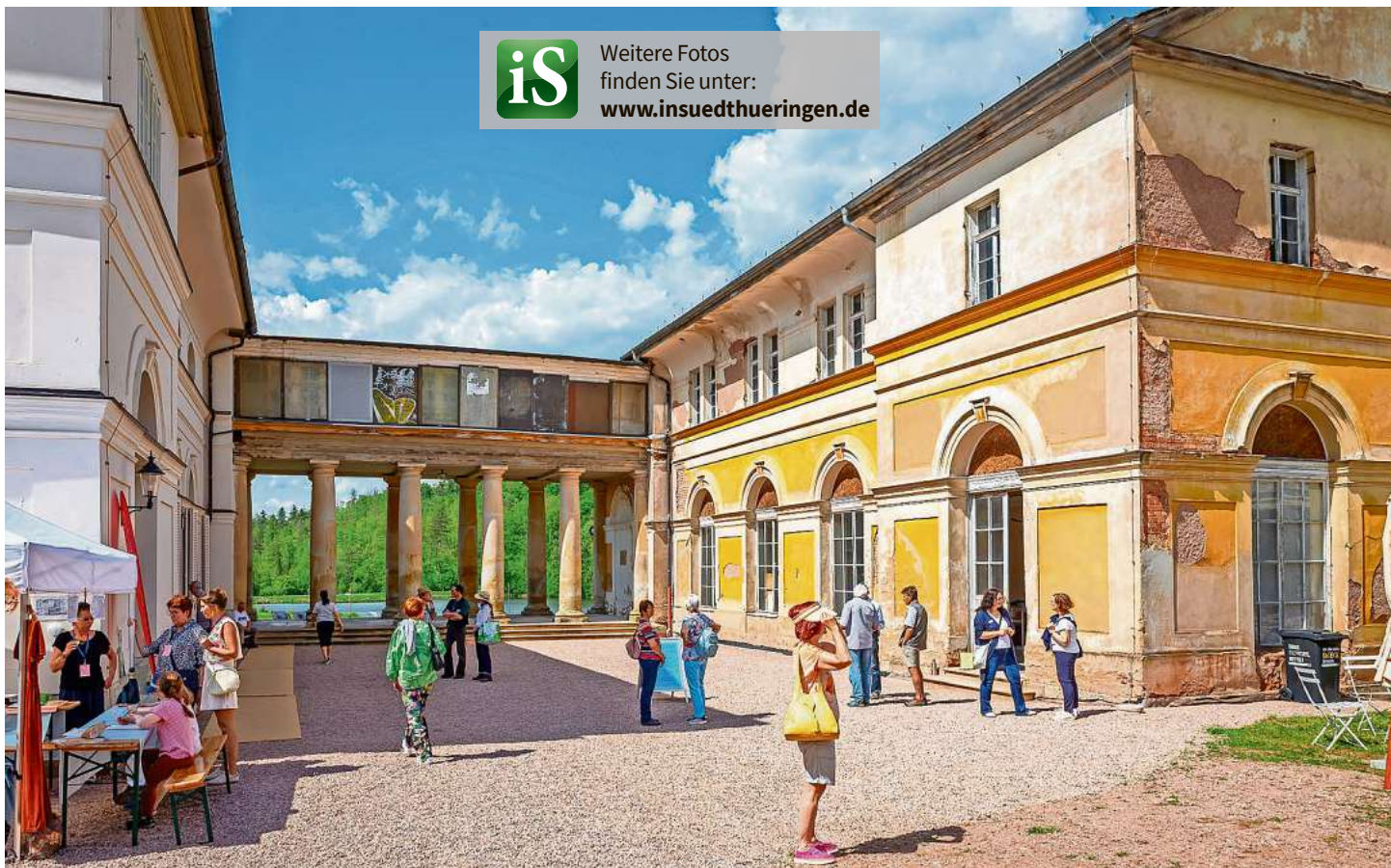
Hauptaugenmerk der Stiftung liegt aktuell auf dem Komplex aus drei Gebäuden – Telemannsaal (links), Prinzengang (Mitte) und Littmannbau – der als neues Schloss bezeichnet wird. Foto: Imogen Berger
