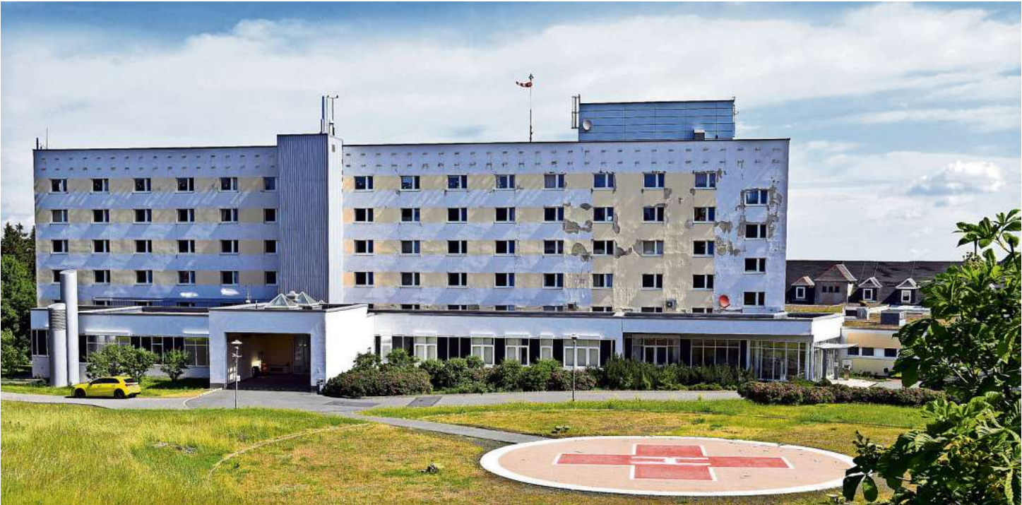
Auf drei Etagen des ehemaligen Rennsteigstadt-Klinikums würde der Kreis sich gern ein Wohnraum-Projekt fördern lassen, das Menschen mit Pflegestufe 1 zugute kommt. Angesichts bereits bestehend hoher Leerstände in Neuhaus fürchten die beiden lokalen Wohnungsunternehmen im Ergebnis massive Verschiebungen zu ihren Lasten. Der Stadtrat schließt sich dieser Skepsis an.
