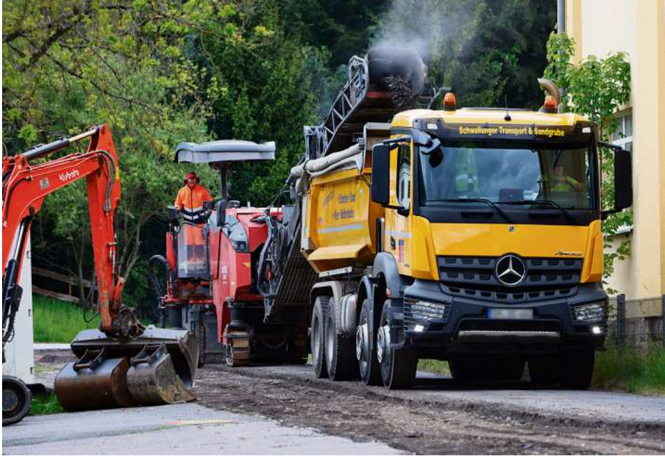
Der grundhafte Ausbau der Poppstraße in Benshausen hat begonnen.
