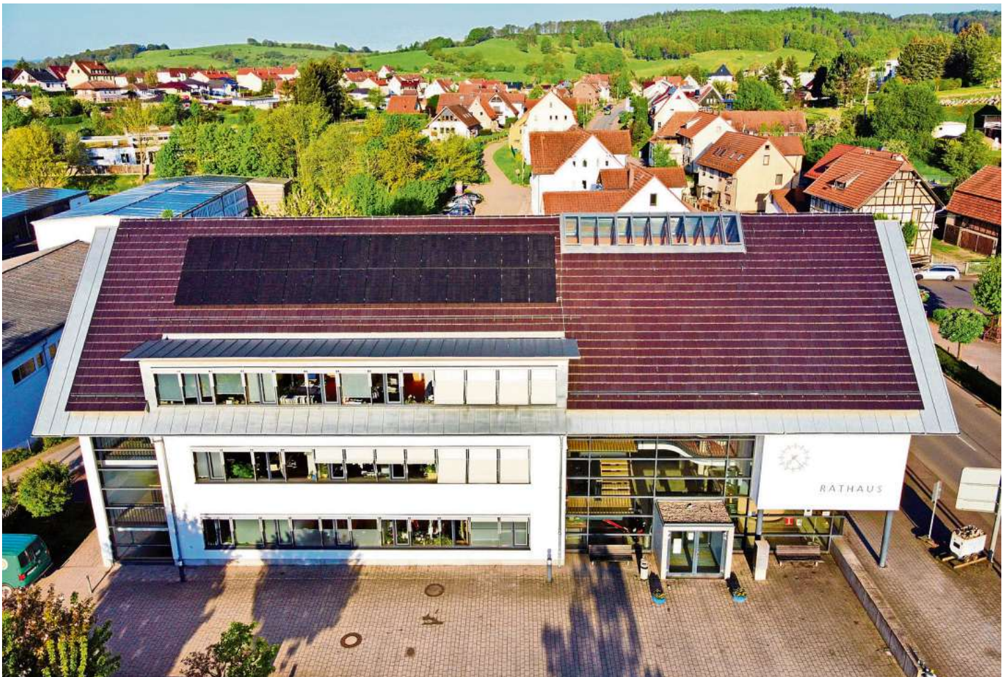
Die PV-Anlage auf dem Trusetaler Rathaus liefert ganz ordentlich.
