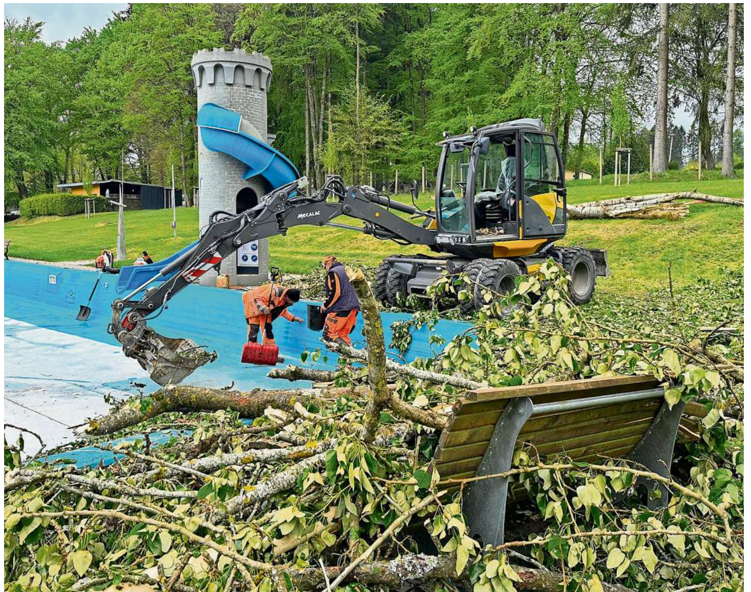
Ralf Sommer (re.) bei der Überprüfung von möglichen Schäden durch Äste am Schwimmbecken.
