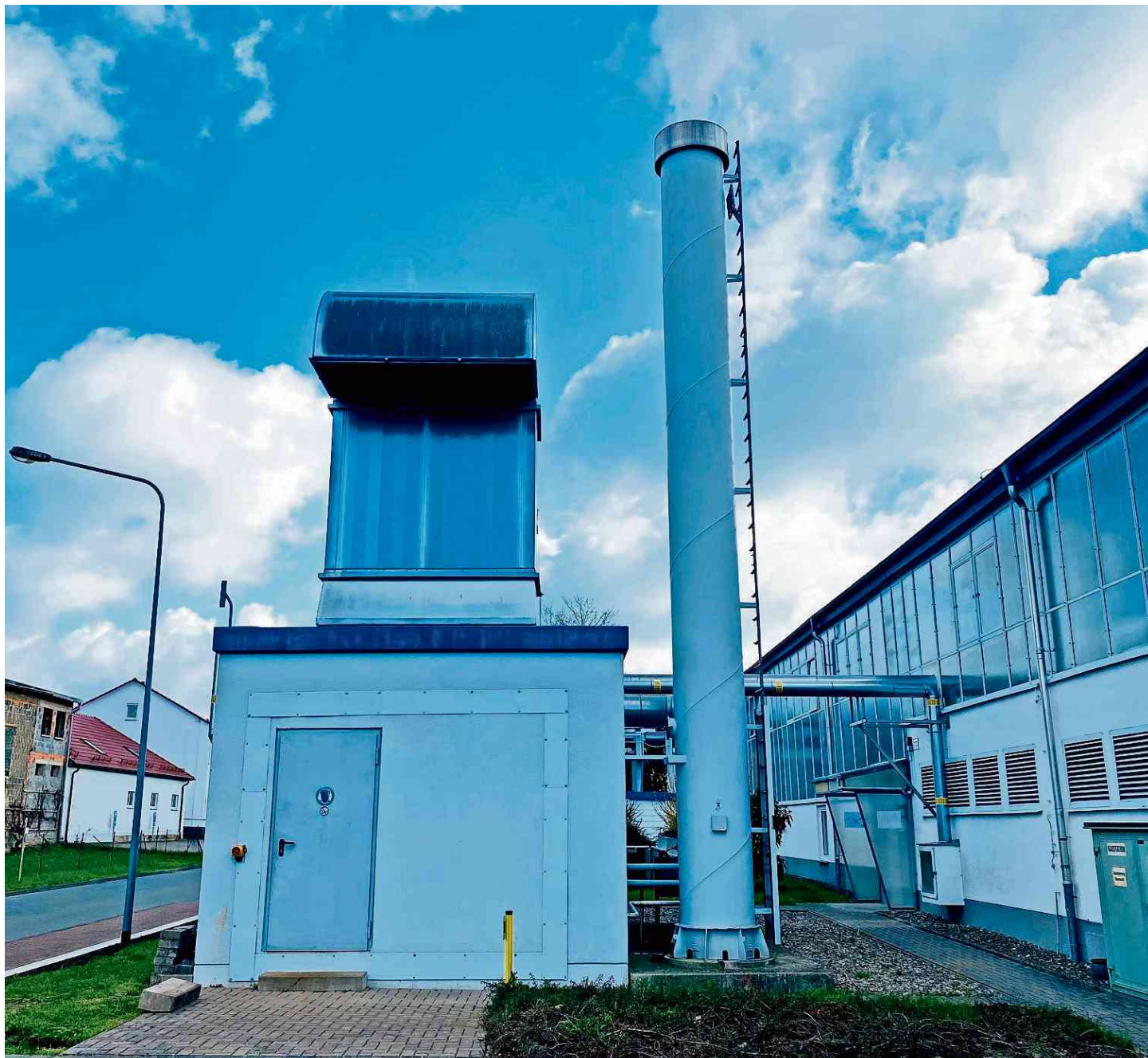
Im Bau: 2024 geht die Anlage in Betrieb.
