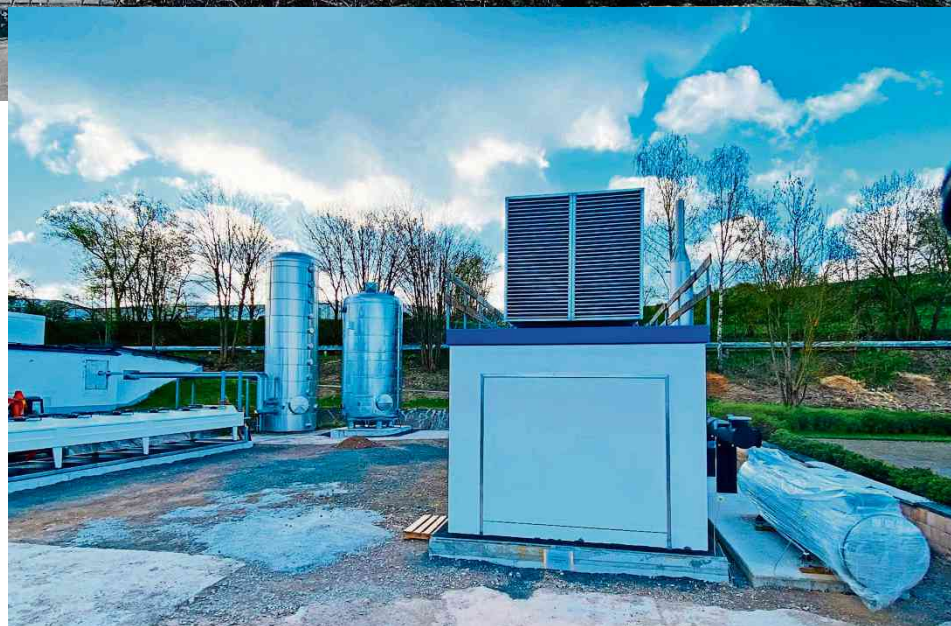
Sichtbarer Baufortschritt An der Asbacher Straße.
