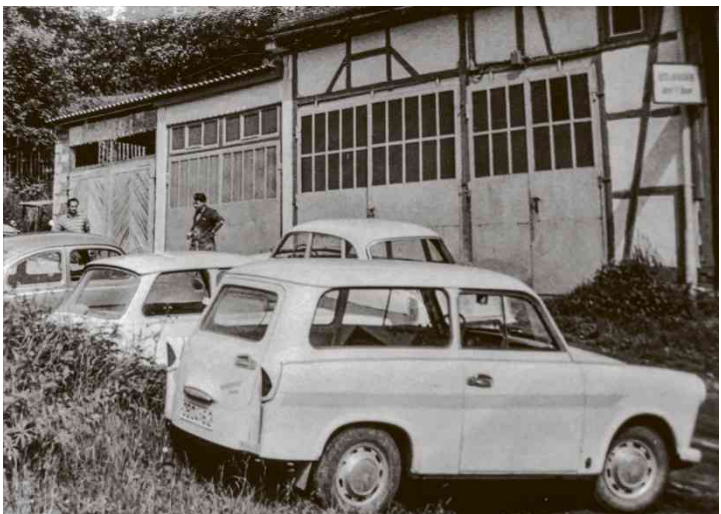
Josef Baum, der die Firma 1963 gegründet hatte, erweiterte später seine Lackierwerkstatt durch einen zweiten Anbau.
