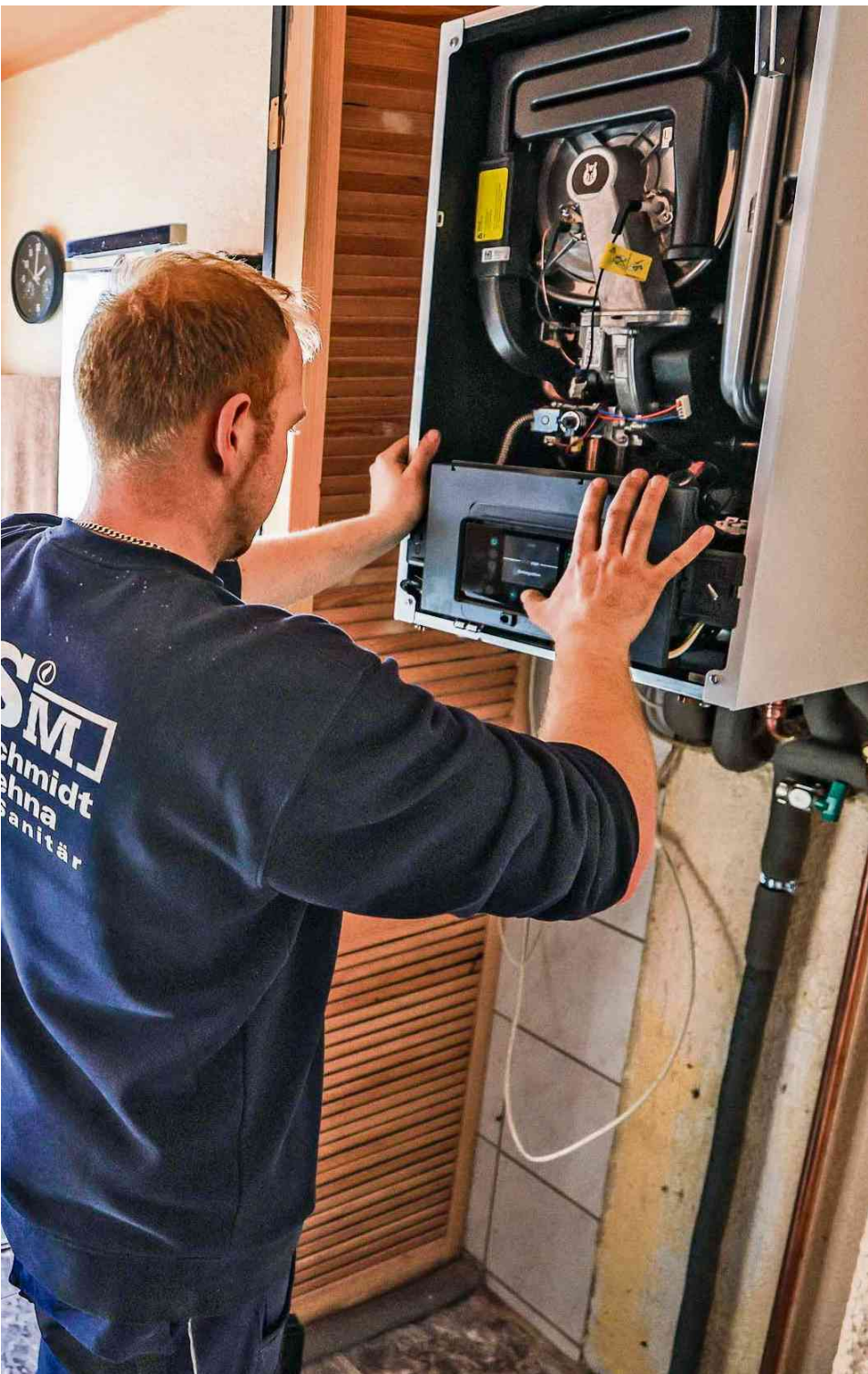
Ein Mitarbeiter einer Sanitär- und Heizungsbaufirma installiert eine moderne Gasbrennwerttherme in einem Einfamilienhaus.
