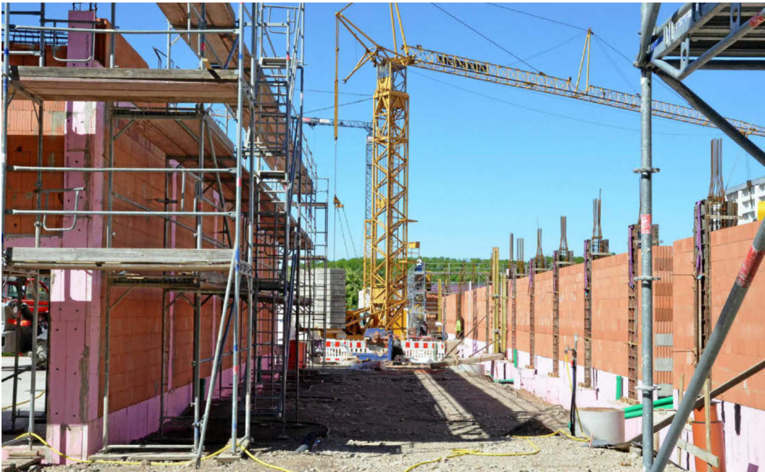
Der Bau des Einkaufszentrums Roter Berg liegt nach Investorenangaben im Zeitplan.
