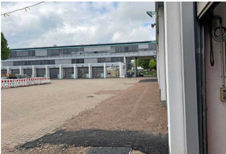
Hinter der Halle ist bereits geschachtet worden. Die Halle mit den Rettungsdienstfahrzeugen (linker Teil des Fotos) soll im Jahr 2027 dran sein.
