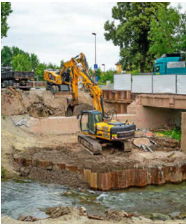
Bei Bauarbeiten entdeckte ein Baggerfahrer die Waffen. Der Fall erinnert an den Fund einer Granate im Juni 2018 unter der Wagenstedter Brücke in Mühlhausen.
