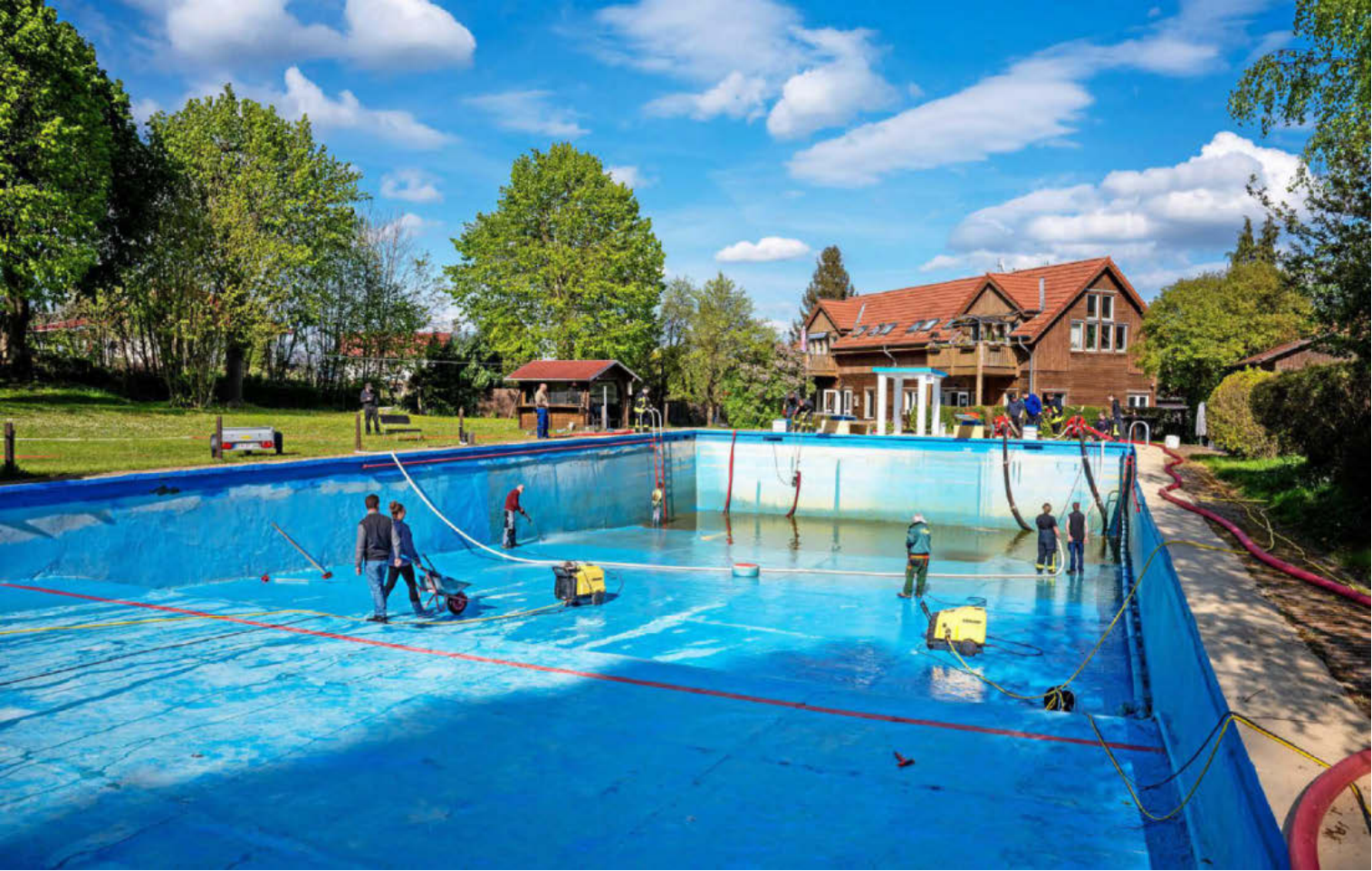
Vor der Saison wird das Becken im Freibad Winterstein stets von Ehrenamtlichen gereinigt, ausgebessert und neu gestrichen. In diesem Jahr ist noch unklar, ob das Bad wieder öffnet. In dem Gebäude im Hintergrund befinden sich die Sanitär- und Technikräume. DIRK BERNKOPF / ARCHIV
