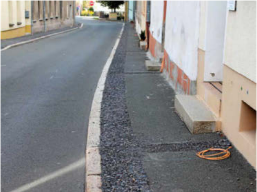
Spuren des Glasfaser-Ausbaus, wie hier im Herbst 2023, gibt es nach wie vor viele (Archivfoto).
