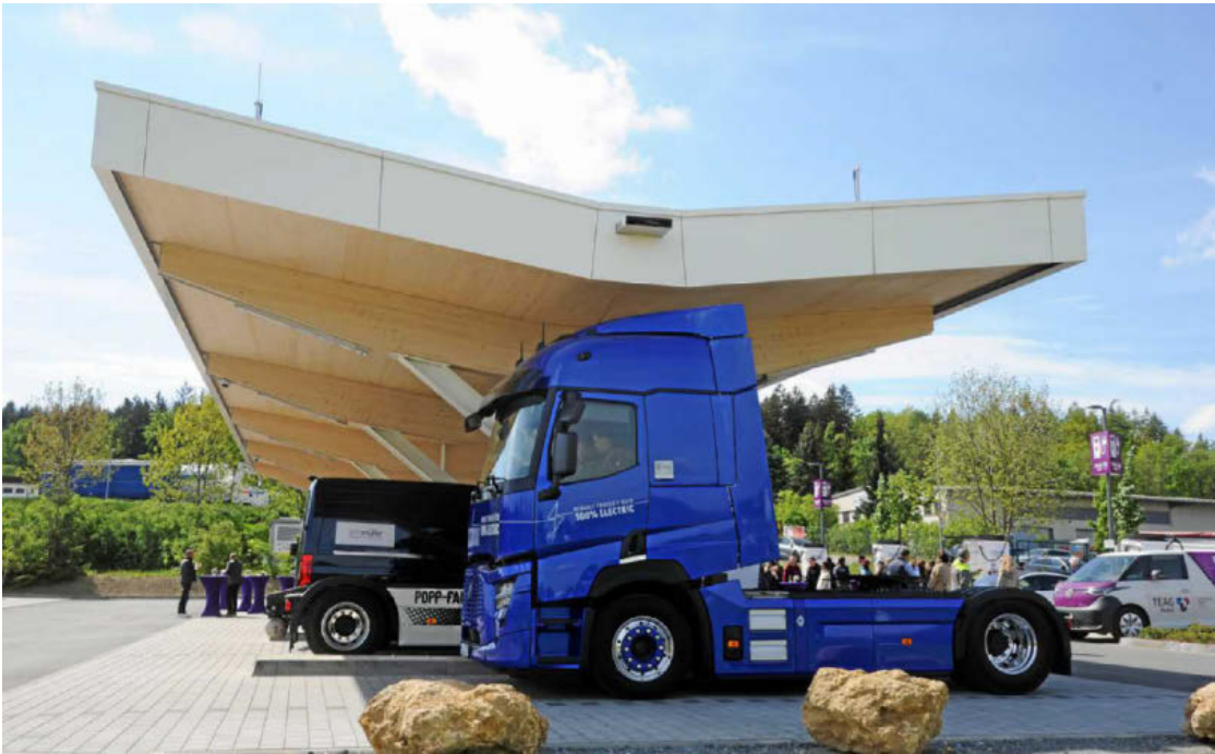
Der neue Ladepark der Teag Mobil GmbH nahe der A 9. Geladen werden können auch die Batterien von Elektro-Lkw.
