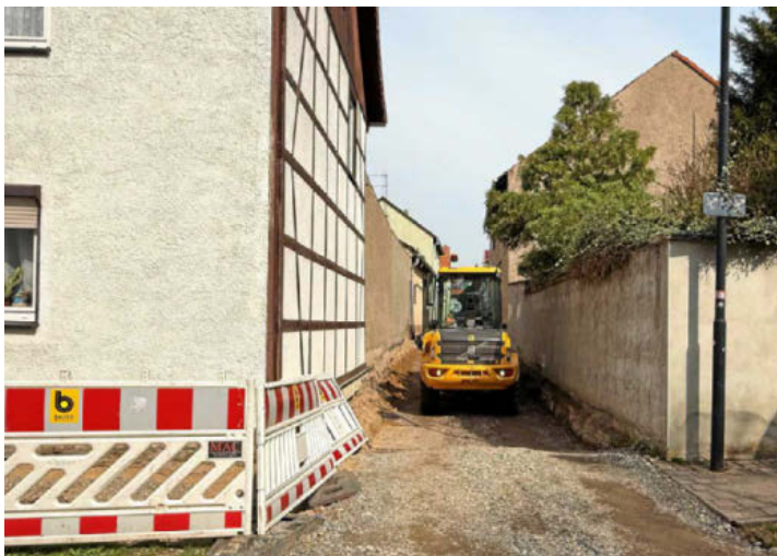
Die Gasse ist nur 85 Meter lang, lediglich fünf Häuser stehen dort.
