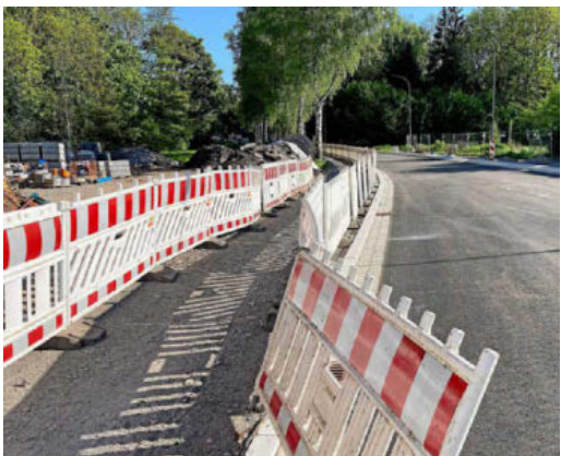
Die Asphalt-arbeiten an der Straße zwi-schen Neudie-tendorf und Kornhochheim sind fast abge-schlossen.
