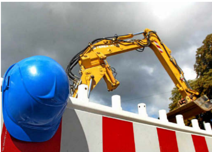
Die Bagger sind bereits angerollt. Sieben Monate sollen die Bauarbeiten in einem Eichsfelder Dorf dauern.
