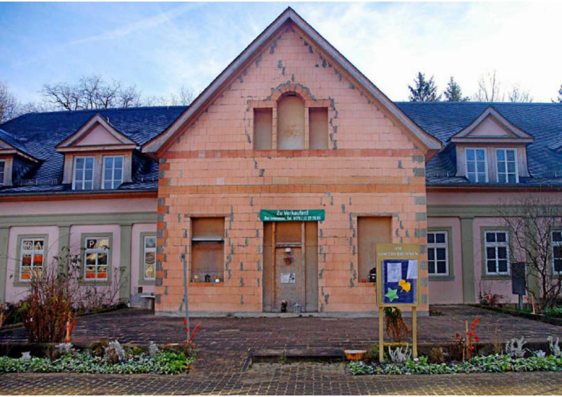
Die Baustelle des Hotels droht seit 2018 zur Investruine zu verkommen.
