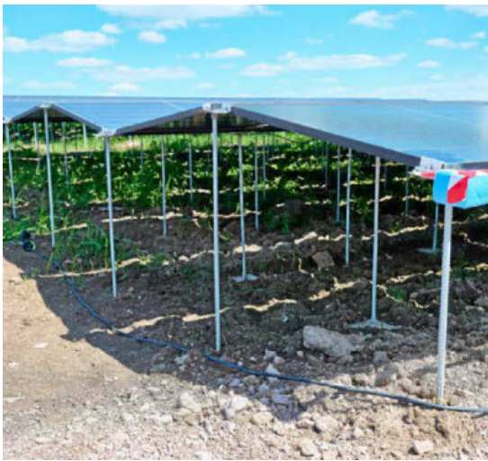
Links: Die rund 9000 Paneele der Anlage werden von mehr als 11.000 etwa 18 Millimeter starken Baustahlstäben getragen. Mitte: Symbolisch stellt Ohrdrufs Bürgermeister Stefan Schambach (Mitte) die Verbindung her. Lukas Greifzu, Projektleiter Teag (von links), Stefan Reindl, Vorstandsvorsitzender der Teag (Thüringer Energie AG), Michael Fischer, Geschäftsführer der Ohra Energie GmbH sowie Chris Maternowski, Leiter der Stadtwerke Ohrdruf, assistieren ihm. Rechts: Große Wechselrichter machen aus dem erzeugten Gleichstrom verbrauchsfähigen Wechselstrom.
