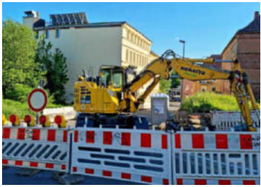
In der Geschwister-Scholl-Straße in Altenburg wird die Stützmauer komplett saniert.
