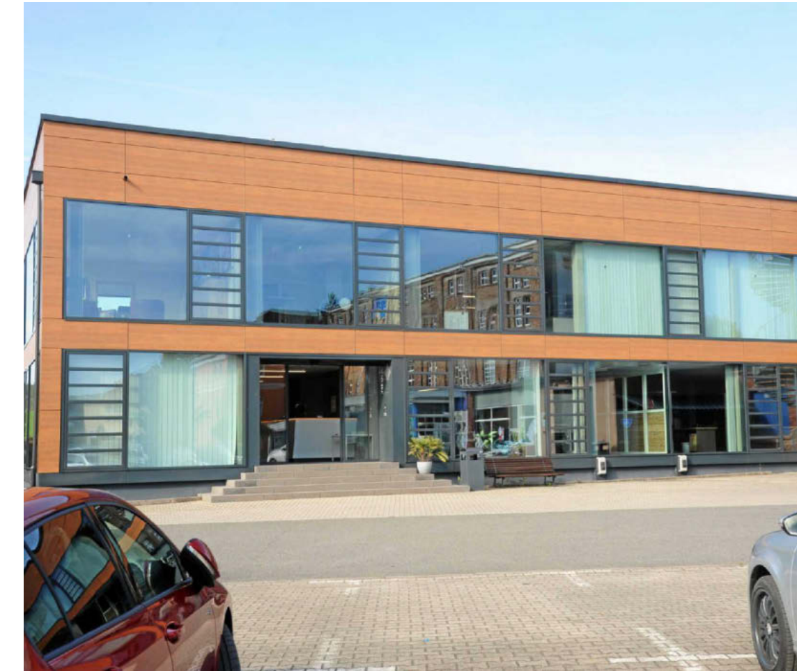
Das Verwaltungsgebäude der Firma NeuLa in der Dimitroffstraße 14 in Neustadt.
