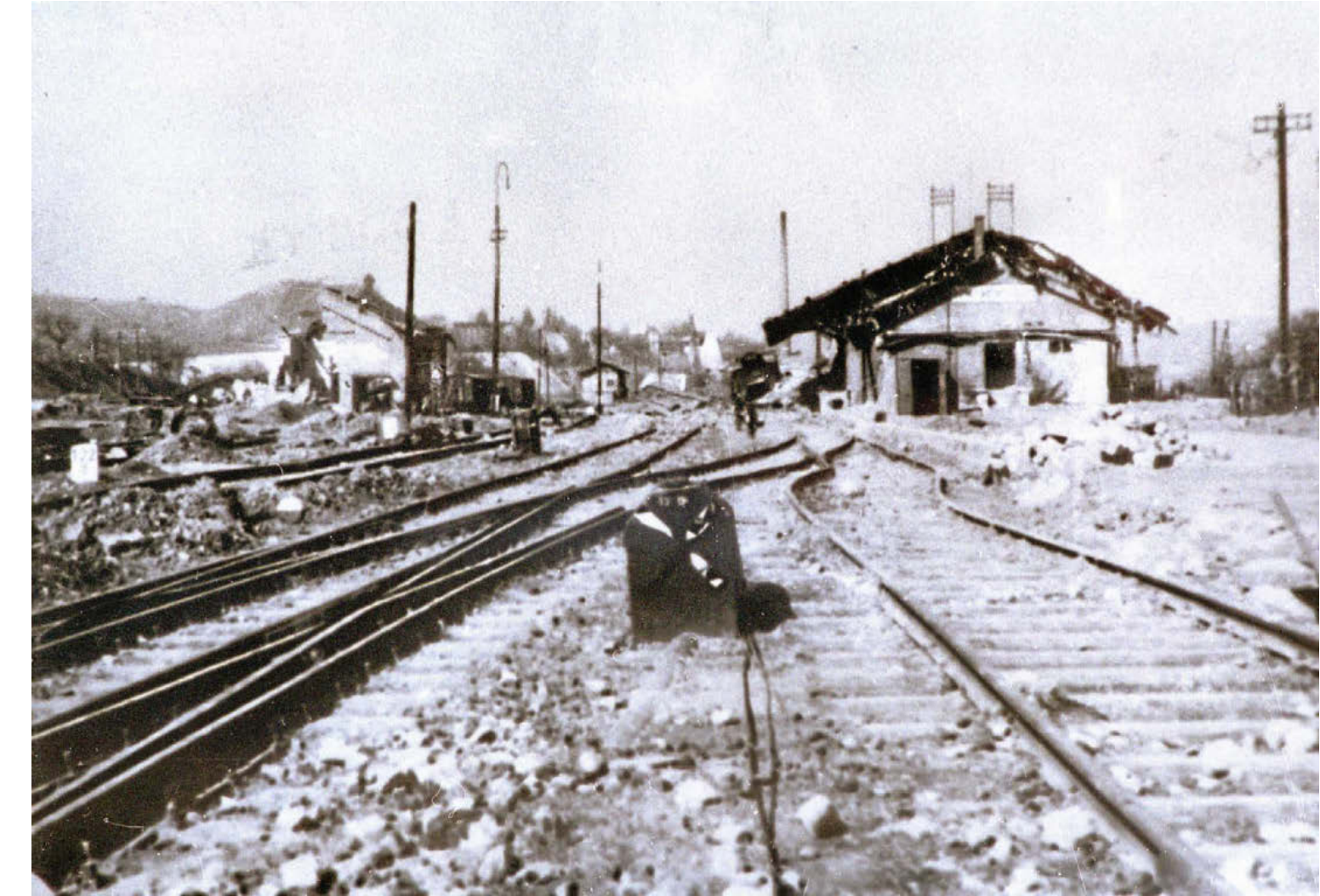
Ausgedehnte und massive Bombenschäden sind am Oberen Bahnhof in Pößneck nach den Angriffen im April 1945 deutlich zu erkennen. Der Güterbahnhof wurde völlig zerstört.
