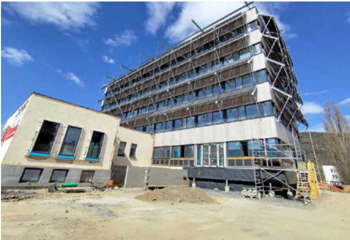
Blick auf die Morgenroth-Baustelle in Bad Blankenburg. DOMINIQUE LATTICH
