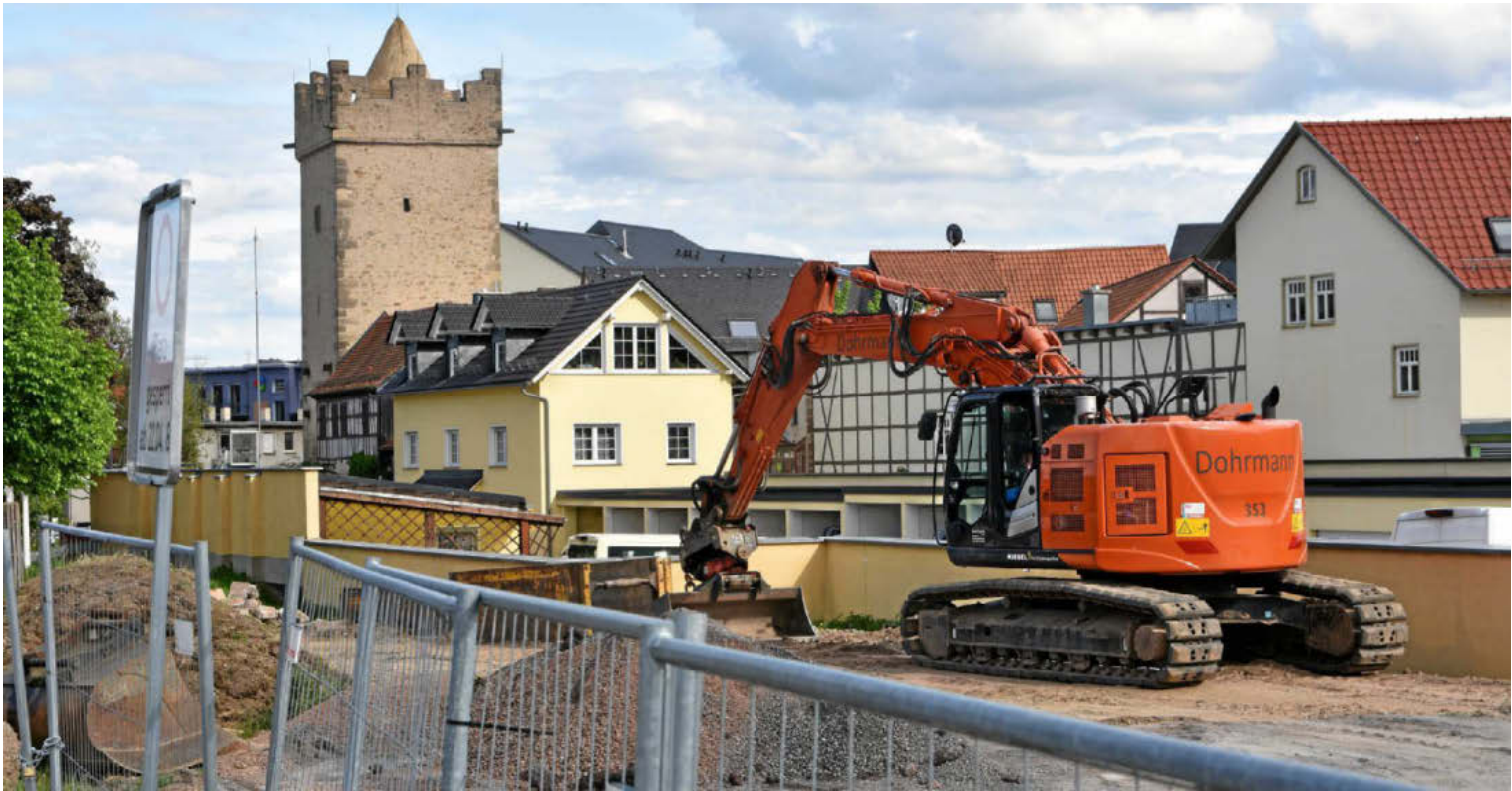
In Saalfeld steht ein Bagger unweit des Darrtores. Was wird dort gebaut? GUIDO BERG
