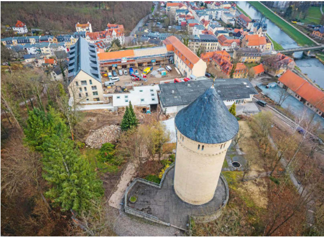
Luftbild von Schloss Osterstein von Anfang April 2025. Der freigelegte Nordflügel, inzwischen teilweise mit einer hellen Filigrandecke überdacht, befindet sich links hinter dem Bergfried. GÖRAN KUGEL
