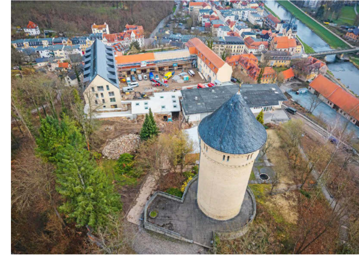
Luftbild von Schloss Osterstein von Anfang April 2025. Der freigelegte Nordflügel, inzwischen teilweise mit einer hellen Filigrandecke überdacht, befindet sich links hinter dem Bergfried.
