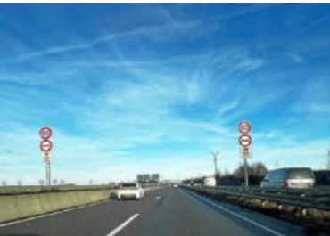
Heute so, morgen so: Die Verkehrsführung am Hermsdorfer Kreuz, hier im Bild die Hauptfahrbahn, wird in nächster Zeit ständig wechseln. AUTOBAHNPOLIZEI
