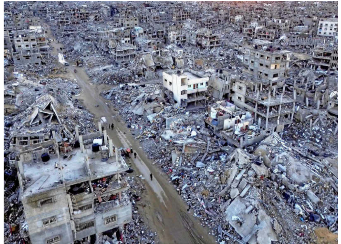
Völlige Zerstörung im Gazastreifen: Luftaufnahmen zeigen, wie es in Rafah aussieht. PA / ASSOCIATED PRESS
