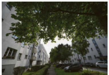
Wohnhäuser des Architekten Ernst May
