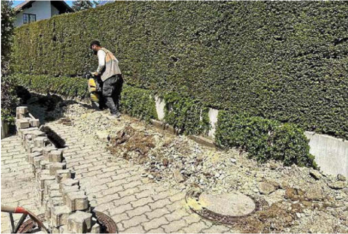
Wer den Glasfaseranschluss bereits beauftragt hat, für den verlegt die Firma Wolke die Leerrohre direkt bis ins Haus.
