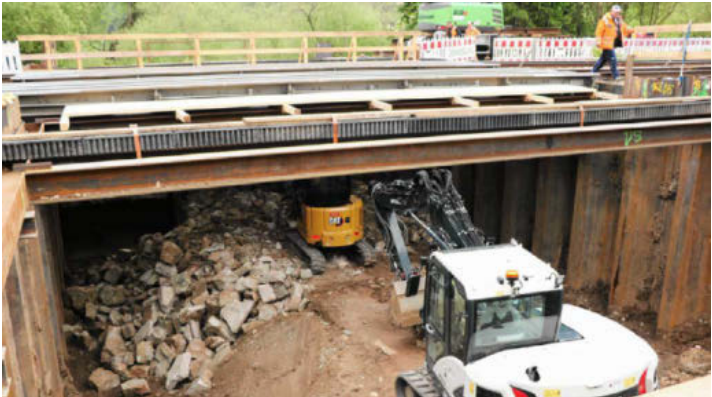
In Kahla ist von der früheren Fußgängerunterführung an der Ernst-Thälmann-Straße nichts mehr übrig. Darüber fahren derzeit nur eingleisig die Züge.
