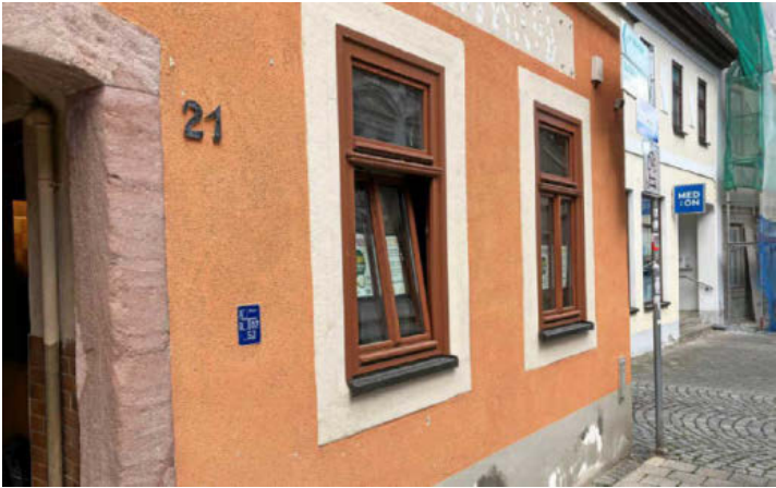
Die 'Kahrola' ist als Nachbarschaftsstube für Jeden ausgelegt und befindet sich in der Rudolf-Breitscheid-Straße 21.
