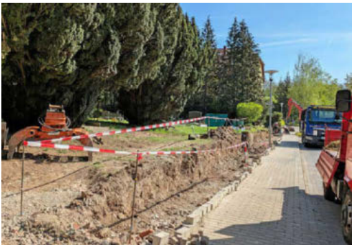
Eine neue Steinmauer soll den Friedhof eingrenzen.
