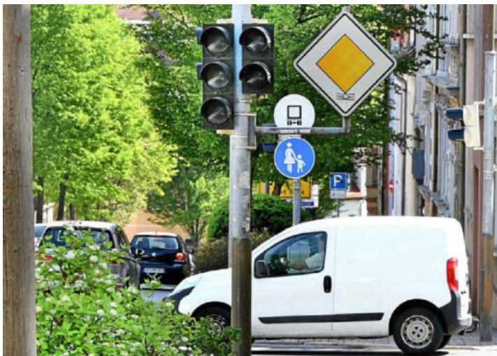
Seit über fünf Monaten ist die Ampel in der Erfurter Straße bereits defekt.
