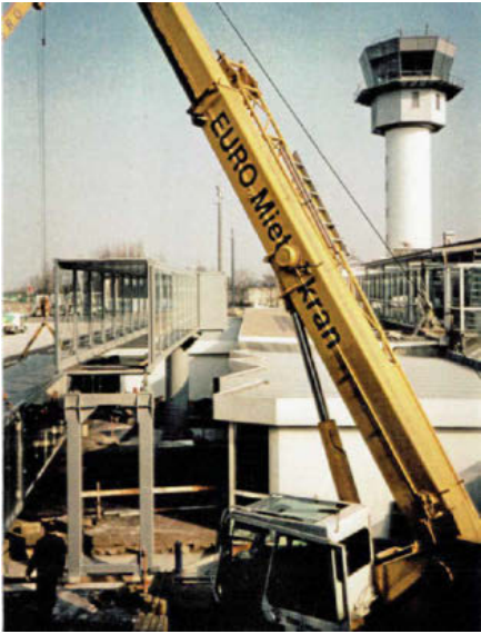
Ein Foto aus dem Jahr 1997 von den Baumaßnahmen am Erfurter Flughafen, hier zwischen den Terminals A und B.
