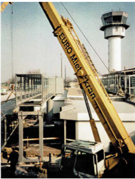
Ein Foto aus dem Jahr 1997 von den Baumaßnahmen am Erfurter Flughafen, hier zwischen den Terminals A und B. ARNDT DIETMAR SCHUMANN
