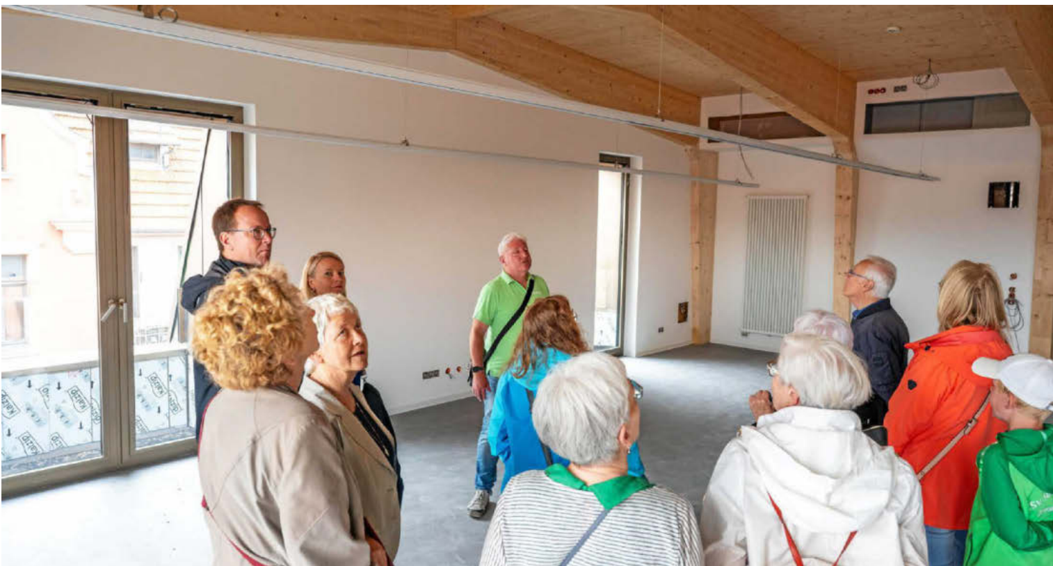
Olaf Riede (Mitte) vom Baumanagement der Baugesellschaft Gotha führte am Tag der Städtebauförderung Besucher über die Baustelle der neuen Jugendherberge in Gotha. Hier sehen sich die Gäste gerade den neu geschaffenen Veranstaltungssaal im Dachgeschoss an.
