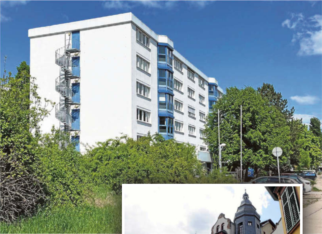
Oben: In diesem Gebäude im Erfurter Norden hat das Thüringer Bildungsministerium Räume für das Institut angemietet. Rechts: Das Thillm-Hauptgebäude in Bad Berka soll saniert werden.
