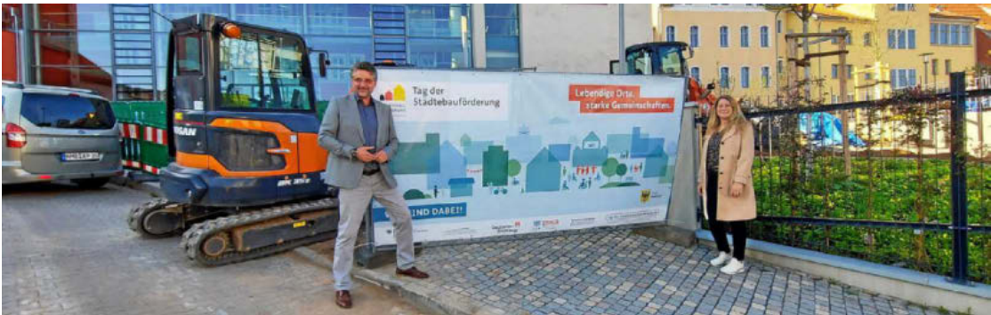
Bürgermeister Frank Spilling und Melanie Brumme stehen vor der Baustelle hinter dem Rathaus, die eine Station der Führung anlässlich des Tags der Städtebauförderung sein wird.
