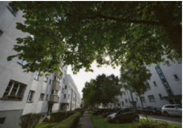
Wohnhäuser des Architekten Ernst May
