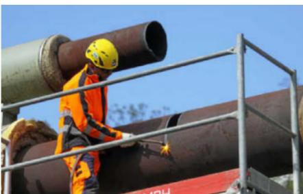
Mit einem Kran werden bereits alte Teilstücke der Leitung entfernt. Zuvor werden diese zertrennt.
