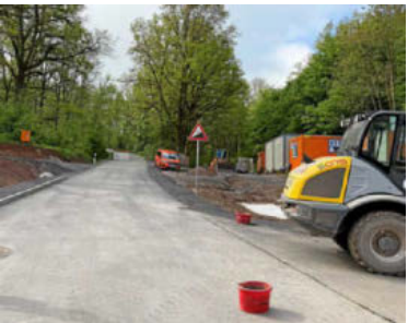
Aktuell finden Restarbeiten an der Verbindungsstraße statt.
