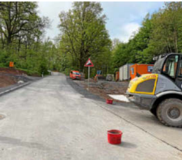
Aktuell finden Restarbeiten an der Verbindungsstraße statt. CHRISTIANE KNEISEL
