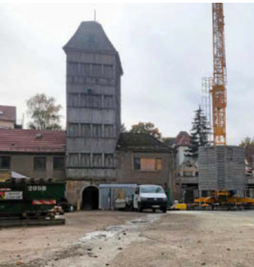
Noch ist dort eine Baustelle, wo voraussichtlich im Herbst 2025 Milch in Bio-Qualität produziert werden soll. Die Bürgermolkerei erhielt bereits jetzt eine Anerkennung beim Thüringer Bio-Preis.
