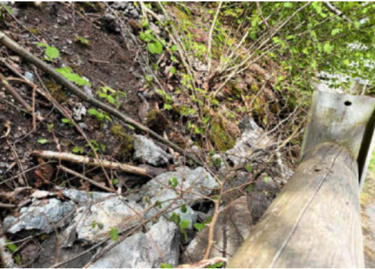
Bild links: Gesteinsbrocken liegen hinter der Prallschutzwand am Hang. Bild rechts: Ein Stück der Prallschutzwand, die Schlimmeres verhindert hat.
