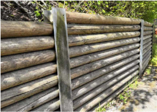
Bild links: Gesteinsbrocken liegen hinter der Prallschutzwand am Hang. Bild rechts: Ein Stück der Prallschutzwand, die Schlimmeres verhindert hat.
