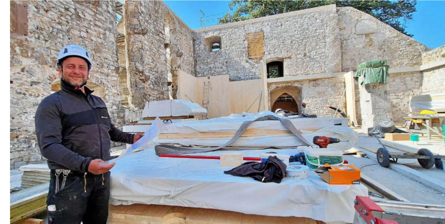
Zimmererleute aus Dingelstädt um Vorarbeiter Martin Winter errichteten in den Mauern der Oberkirche eine Holzständerkonstruktion als Basis für den Innenausbau des künftigen Besucherzentrums.
